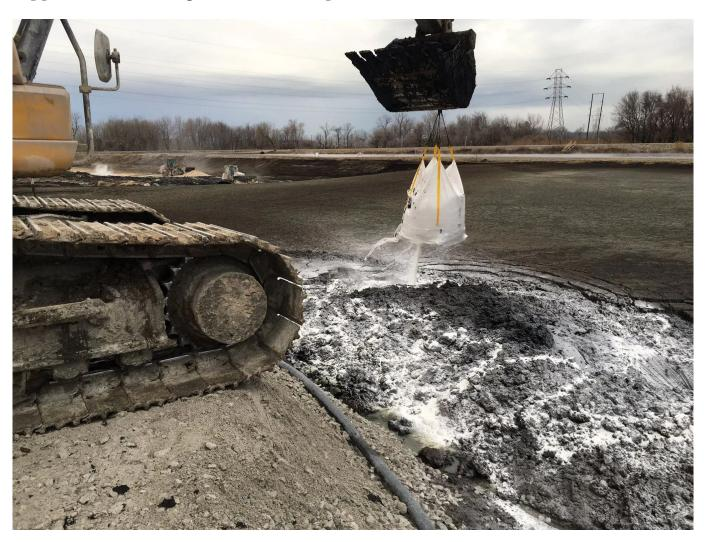
I polimeri superassorbenti (SAP) WELLDONE sono ampiamente utilizzati dagli appaltatori di bonifica dei siti per solidificare rapidamente i rifiuti contenenti liquidi in loco per il trasporto e lo smaltimento nelle discariche di rifiuti solidi.
