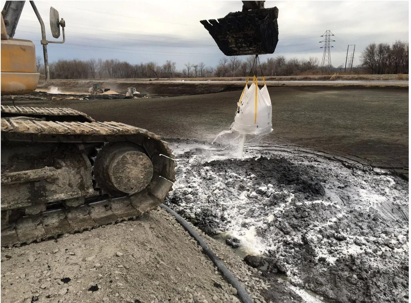
WELLDONE Superabsorbierende Polymere (SAP) werden häufig von Sanierungsunternehmen verwendet, um flüssigkeitshaltige Abfälle vor Ort für den Transport und die Entsorgung auf Deponien für feste Abfälle schnell zu verfestigen.
